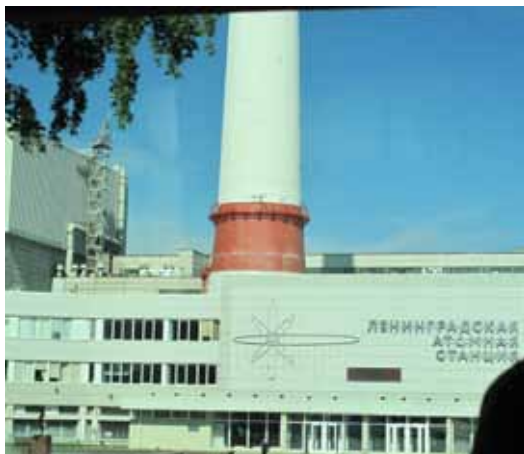
Rusko - Leningradská atomová elektrárna
