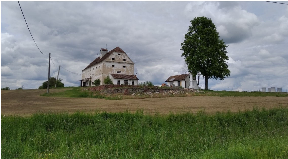
Obr. 14: Sýpka nacházející se v blízkosti zámku Zdroj: ENVIPARTNER, s.r.o. (2021)
